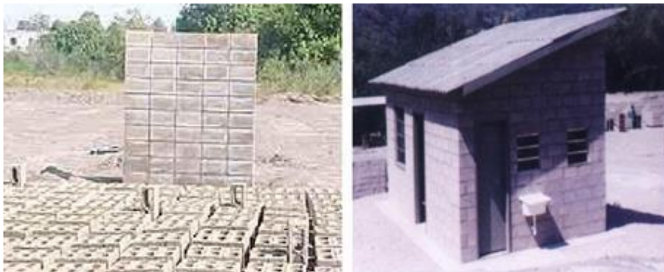
Figura 19- Blocos e casa popular, feitos a partir do material de demolição do Edifício Andorinhas.
