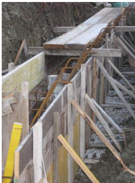
Figura 6- Estrutura de aço, madeira e concreto
