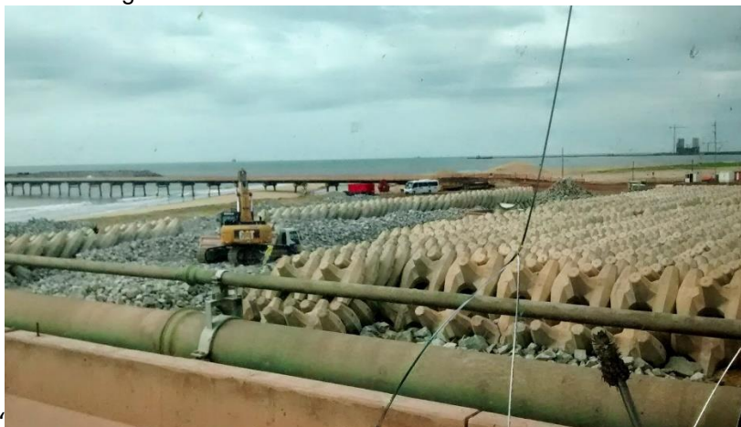
Figura 13- Corelocs estocados e sendo destruídos
