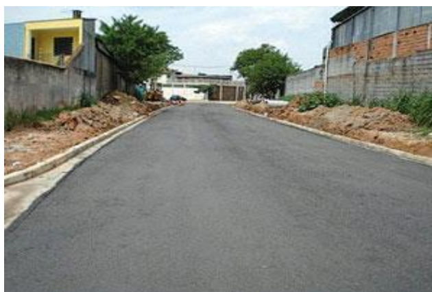
Figura 17- Pavimento de asfalto feito com adição de agregado reciclado
