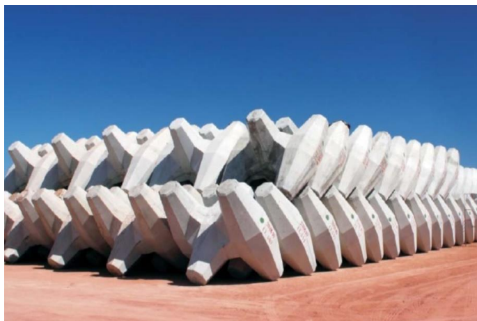
Figura 1: Armazenamento dos Corelocs
